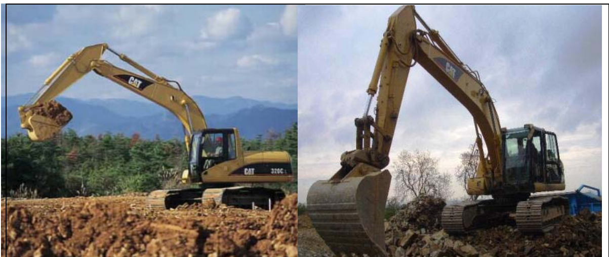
Figura 1.2. Excavadora CATERPILLAR 320 C
