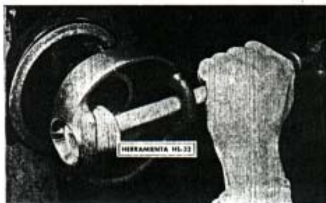
Fig. 275. — Extrayendo la cubeta del cojinete del perno de punta de eje, con la herramienta HS-32.
