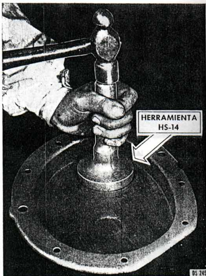
Fig. 104. — Instalando el retén de la tapa de distribución.
